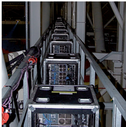
Amp-city op de catwalk achterin het stadion.
